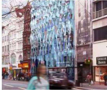
صورة رقم (13) ... توضح مبني private investor، ويتضح دقة تشكيل الواجهات واختلافها عن طابع الشارع الكلاسيكي والدمج بين الدور الأرضي والأول للحفاظ على الإيقاع.
